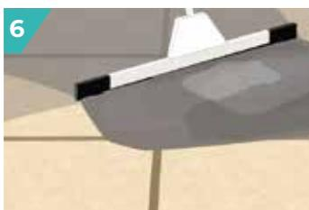
6 Après 24 heures minimum, jointoyer avec **JOINT SOUPLE UNIVERSEL**. Interdire l'accès au local pendant 24 heures.
