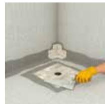
Étaler **FLEXÉTANCHE ULTRA** à la lisseuse inox sur le sol et en relevé, sur une largeur suffisante. Régler avec un peigne U4 permet d'obtenir la bonne quantité de produit sous les différents accessoires.
