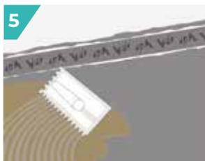
**5** Après 4 h, coller le carrelage avec **COLLIMIX TERRASSE**. Lors de la pose, ménager un vide périphérique de 5 mm le long des murs et des poteaux. Pratiquer toujours un double encollage en beurrant de colle le revers de chaque carreau à l'aide d'une truelle ou de la partie non crantée d'un peigne à colle.
