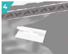
**4** Attendre 4 h (à +20° C) puis appliquer la seconde passe de 1,5 kg/m<sup>2</sup> de **FLEXÉTANCHE ULTRA** sur la première à la lisseuse.
