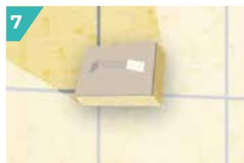
Nettoyer à la taloche éponge ou à l'éponge humide, toujours en diagonale, sans creuser le joint. Après séchage complet, éliminer e voile de ciment avec un chiffon propre et sec.
